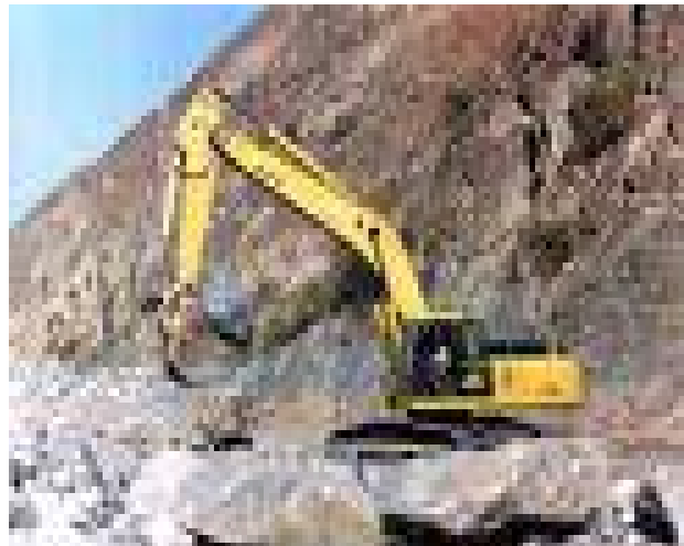
Figura 6.7. Volcado del enrocado con maquinaria
