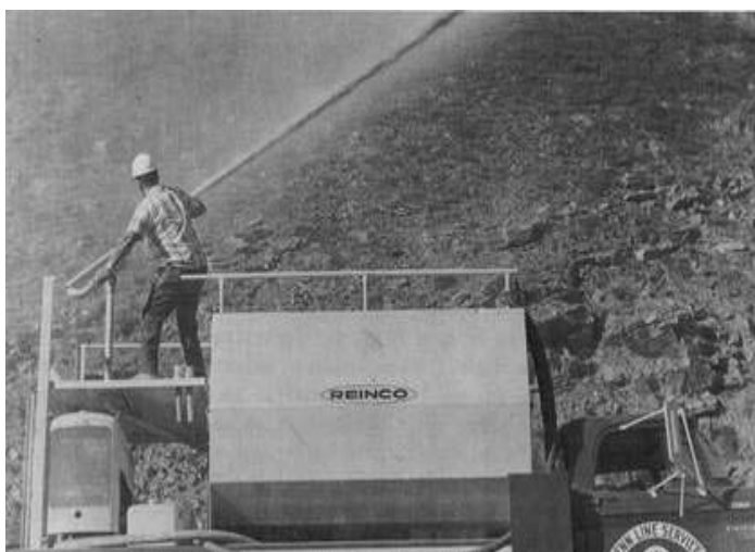
Figura 8.5 Siembra mediante sistema hidráulico (hidrosiembra)
