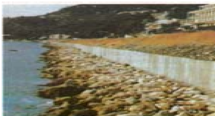
Figura 6.9. Muro de contención protegido con enrocado
