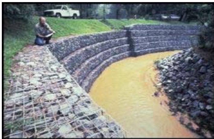
Figura 6.25. Protección de suelos fértiles empleando gaviones
