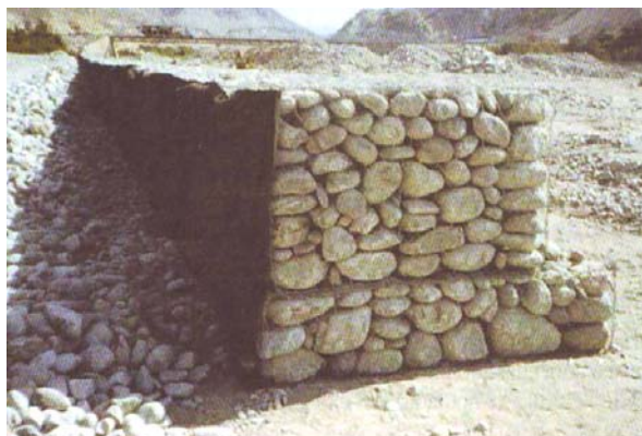
Figura 6.23. Representación de un gavión
