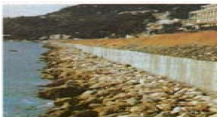
Figura 6.9. Muro de contención protegido con enrocado
