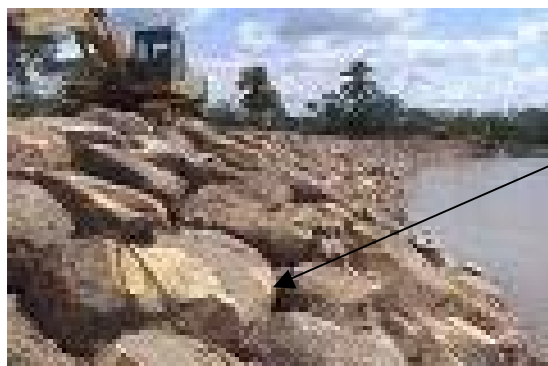
Figura 6.5 Fotografía de un enrocado con roca colocada
