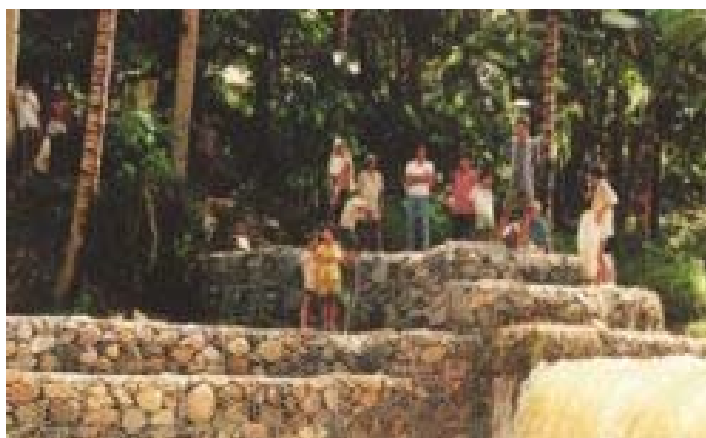
Figura 6.24. Muros de contención formados por gaviones
