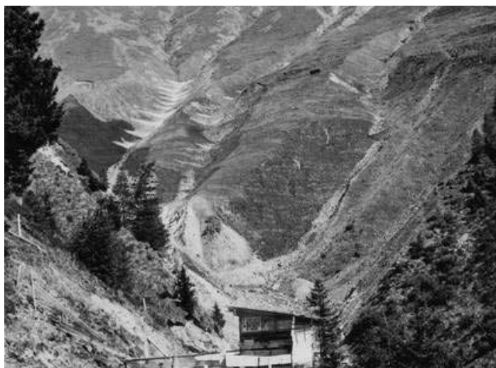
Figura 8.7. Estabilización de grandes laderas y de cauces erosionados mediante la construcción de diques de retención (a la izquierda), el método de Schiechteln (en el centro) y plantación (a la derecha)
