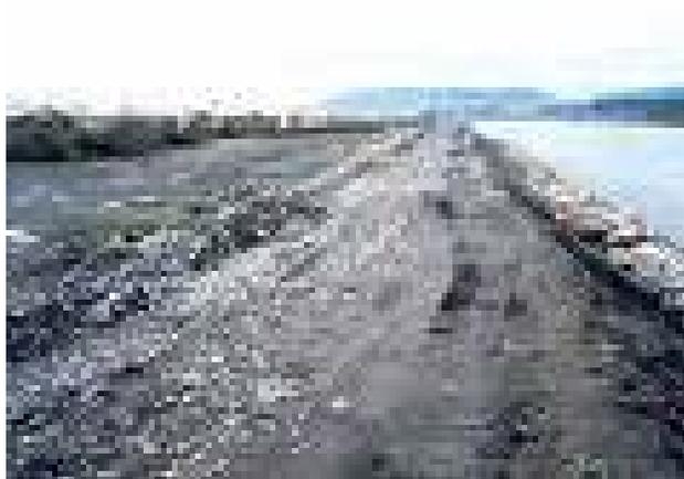
Figura 6.4. Talud peinado con maquinaria
