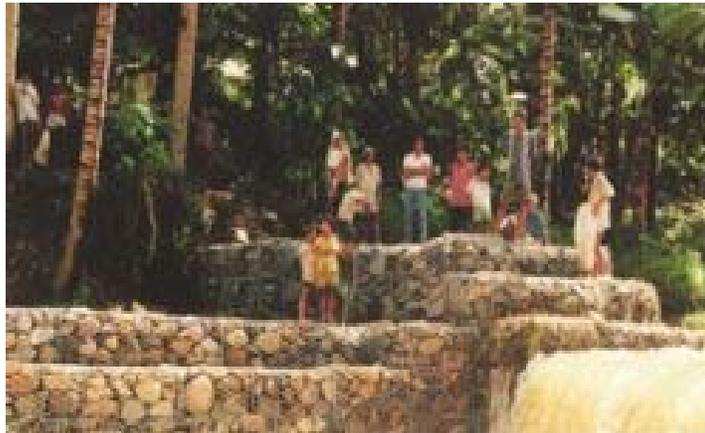
Figura 6.24. Muros de contención formados por gaviones
