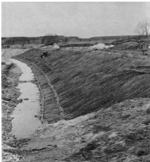
Figura 8.1. Construcción de un colchón de ramas
