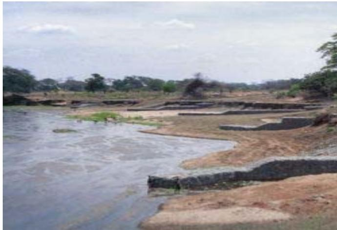
Figura 6.26. Control de ríos usando gaviones
