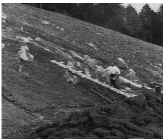
Figura 8.4. Protección de una ladera mediante recubrimiento con planchas de césped de pastizal natural
