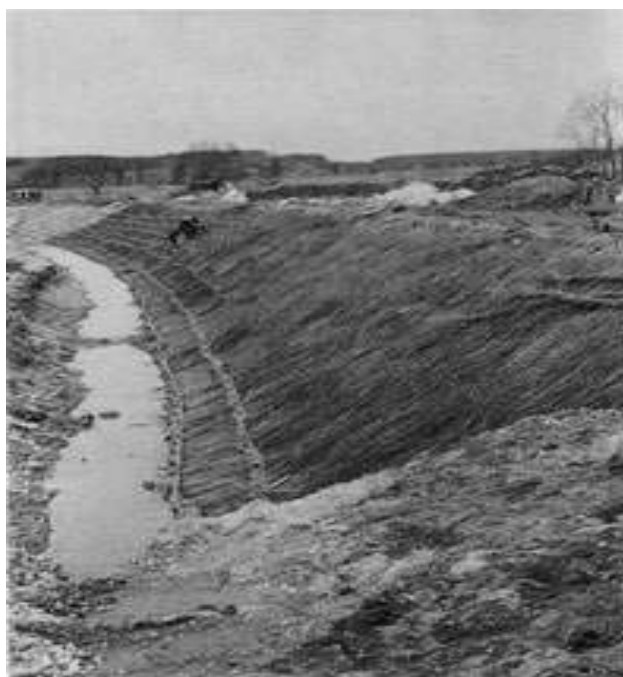
Figura 8.1. Construcción de un colchón de ramas
