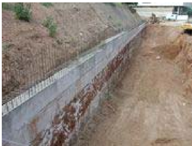
Figura 6.11. Construcción de un muro de contención previa desviación del río
