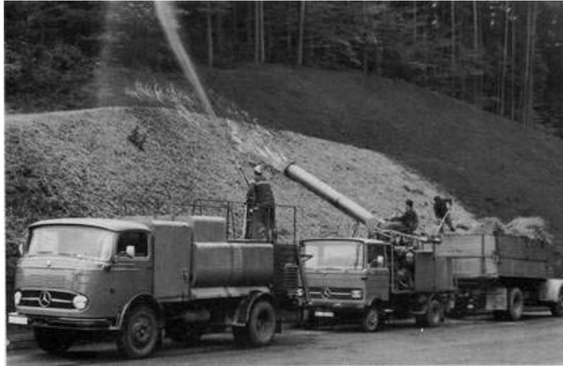
Figura 8.6. Siembra de recubrimiento con distribuidor de paja después de la siembra hidráulica
