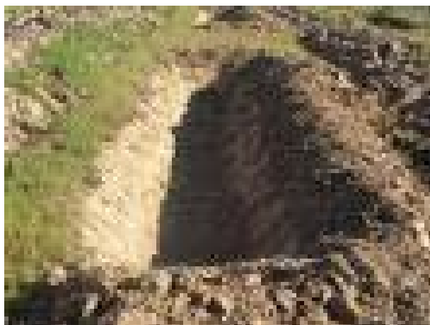
Figura 4.9. Colocación de la tierra extraída en el borde inferior de la zanja
