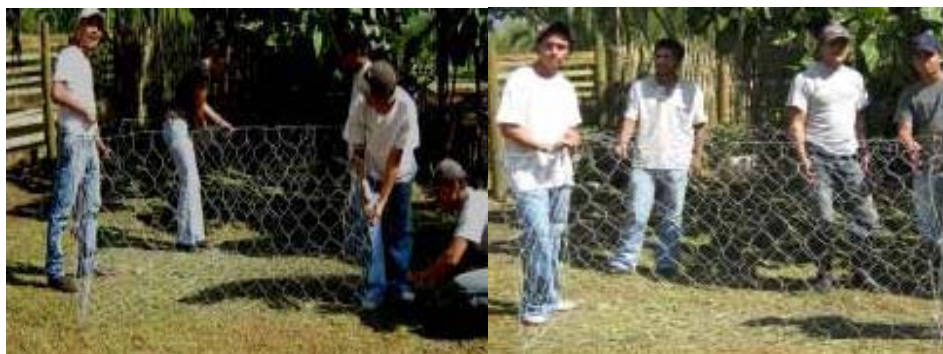
Figura 6.29. Armado de la malla de alambre
