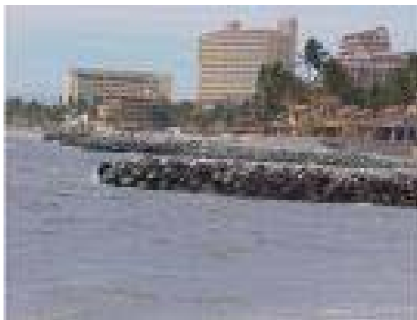
Figura 7.1. Vista de un espigón colocado en la orilla de una costa
