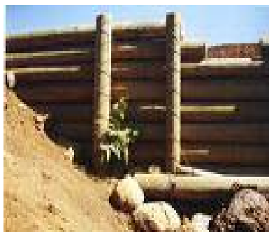
Figura 4.15. Cárcavas tratadas con palos, ramas
