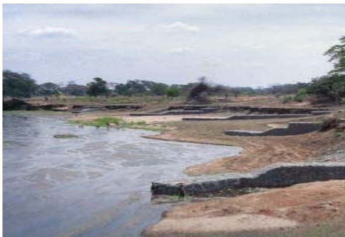
Figura 6.26. Control de ríos usando gaviones
