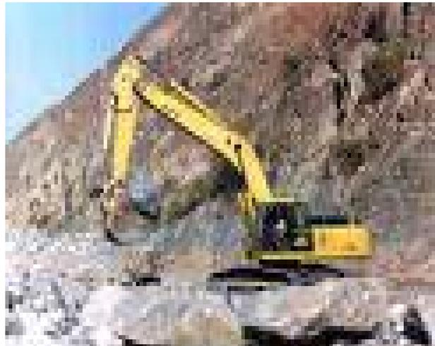
Figura 6.7. Volcado del enrocado con maquinaria
