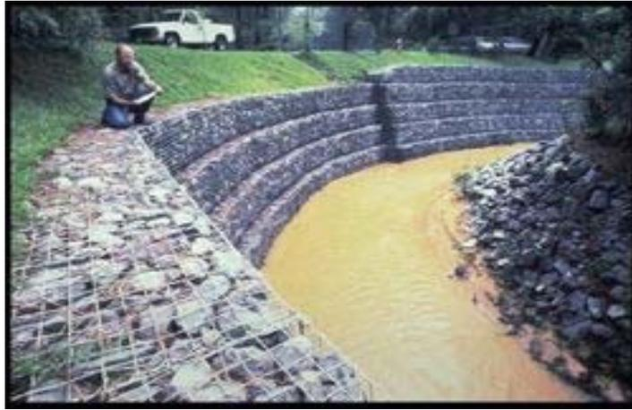
Figura 6.25. Protección de suelos fértiles empleando gaviones
