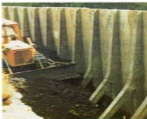
Figura 6.14. Relleno de la cara posterior del muro con maquinaria
