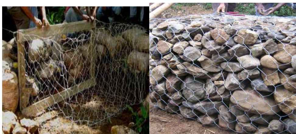
Figura 6.30. Llenado de los gaviones con piedras
