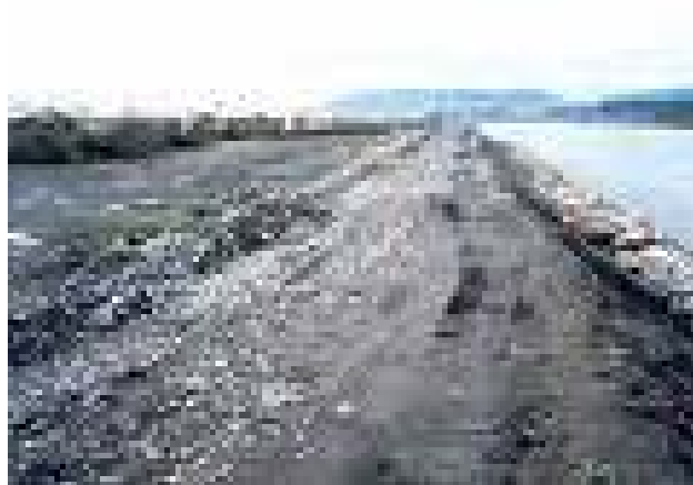
Figura 6.4. Talud peinado con maquinaria
