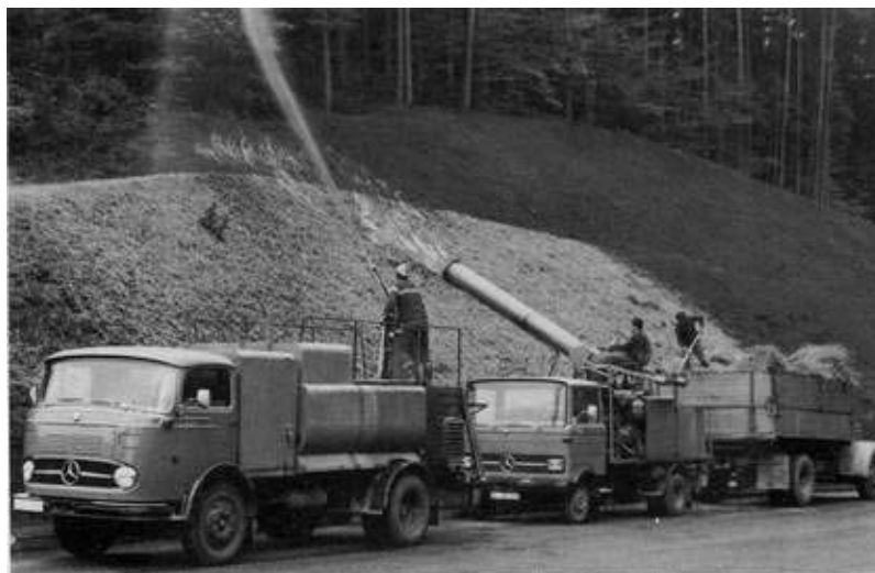
Figura 8.6. Siembra de recubrimiento con distribuidor de paja después de la siembra hidráulica
