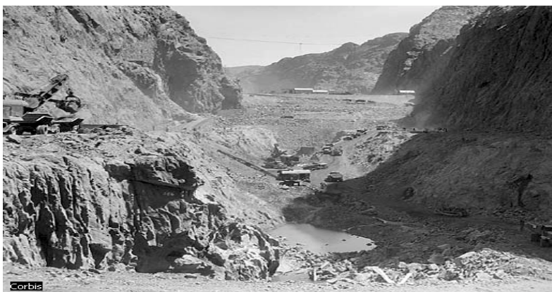
Figura 6.21. Preparación de cimientos para la construcción de una presa
