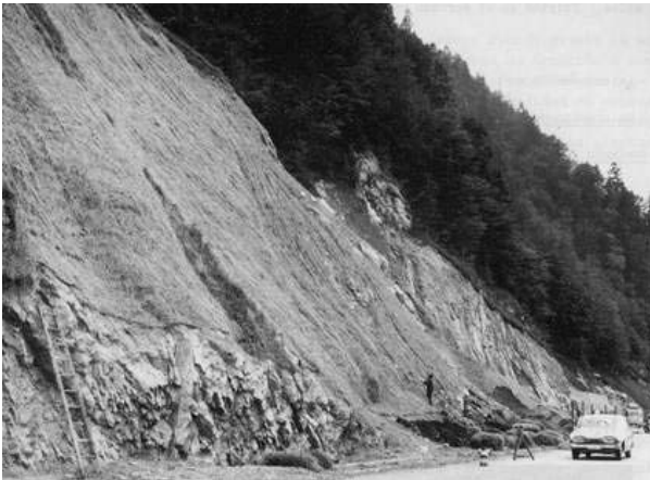
Figura 8.8. Colocación de alfombras de semilla reforzadas en laderas inclinadas
