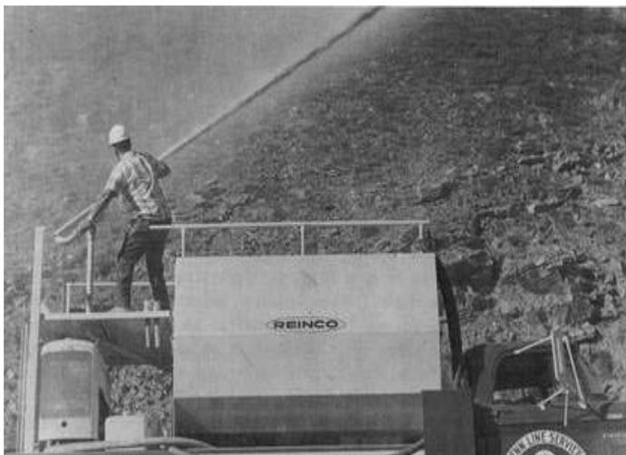
Figura 8.5 Siembra mediante sistema hidráulico (hidrosiembra)
