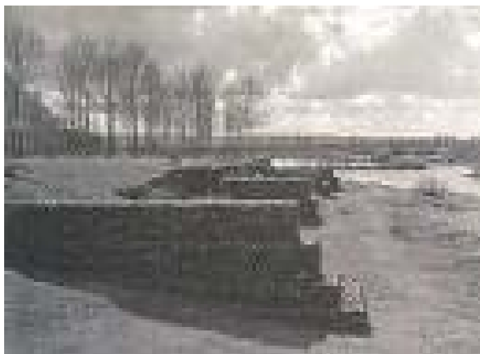
Figura 7.7. Espigones dirigidos aguas arriba
